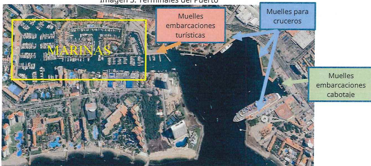
Imagen 3. Terminales del Puerto
