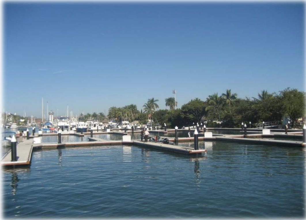
Estas instalaciones tienen fundamentalmente el propósito de ordenar y controlar de manera adecuada el atraque de estas embarcaciones menores que utilizan este espacio de agua y permitir que la plataforma de embarque facilite las operaciones de embarque y desembarque con las variaciones de la marea lo que brinda mayor seguridad a los usuarios.
